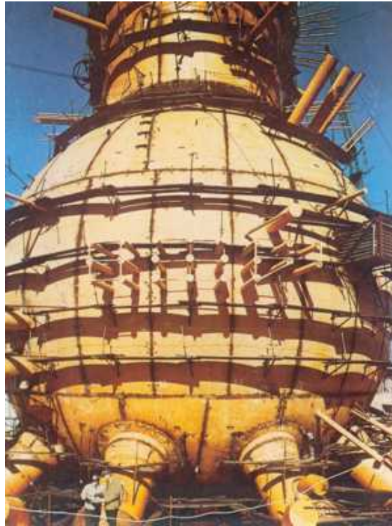
Construcción de un reactor nuclear en Illinois (EE.UU.)
